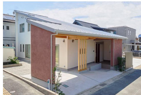
完成したモデルハウス 前向き住宅グループHPより掲載
