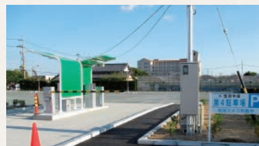
新設の第4駐車場
